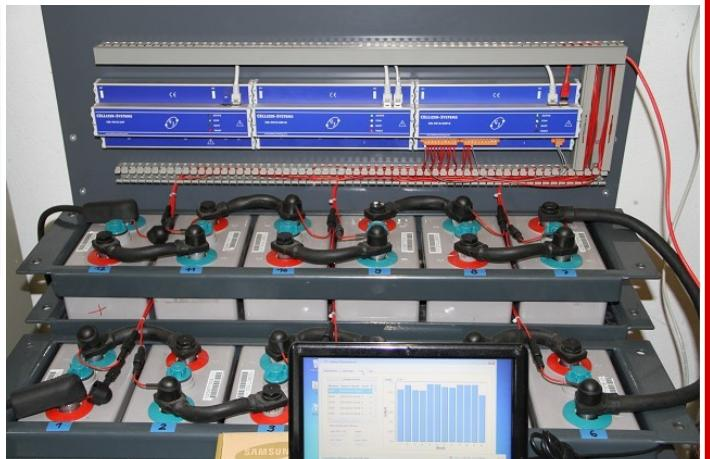
Es können Batterien, Gleichrichter, die zugehörige Einspeisungen und die USV-Ausgänge gleichzeitig überwacht, alle Parameter in Tabellenform und/oder in Diagrammen visualisiert und direkt an der Anlage oder, im Zuge der Fernwartung, an jedem beliebigen Standort auf einem Server erfasst und ausgewertet werden.
