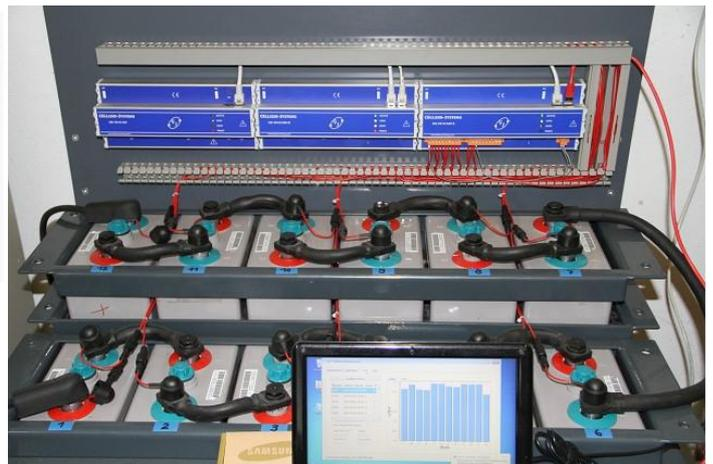
Je nach Kundenanforderung erstreckt sich der Einsatzbereich von einer einfachen Blockspannungsüberwachung, bis hin zur kompletten Anlagenüberwachung (z.B. 150 USV-Systeme mit insgesamt 5'000 Blöcken).
